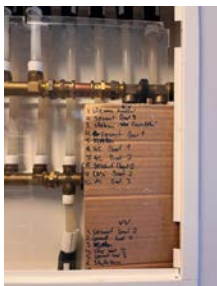
Rørkurser er ikke merket i fordelerskapet.
