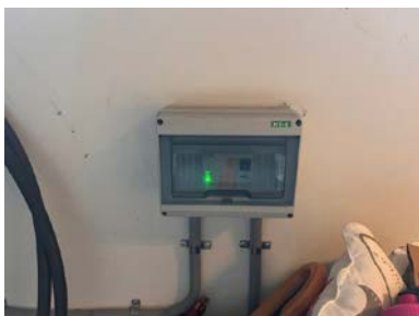
Sikring for bil lader plassert i garasje.
