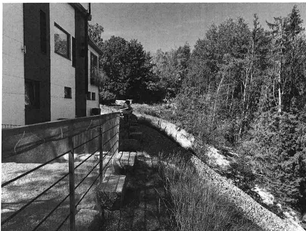
Figur 3-2. Bilde av skråningen fra øst. Datert 26. juli 2018.
