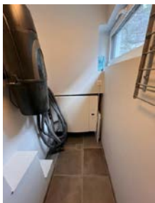
Rør fra radonbrønn under den lille flisen?
