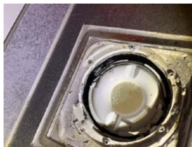
Synlig mansjett under klemring i sluket.
