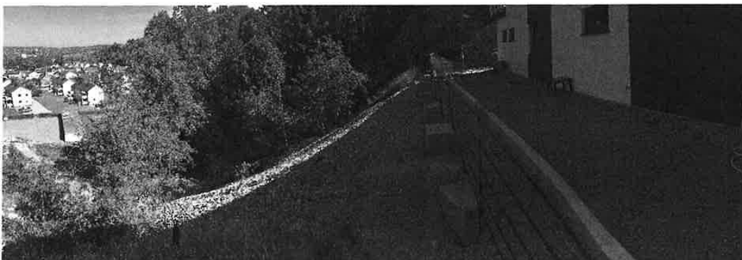
Figur 3-1. Panoramabilde av skråningen fra vest. Datert 26. juli 2018.
