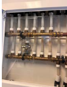
Rørkurser er ikke merket i fordelerskapet.
