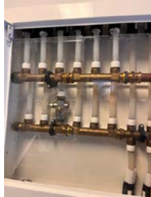
Rørkurser er ikke merket i fordelerskapet.
