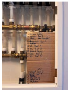
Rørkurser er ikke merket i fordelerskapet.
