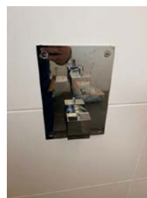
Drensåpning for innebygd blande batteri.
