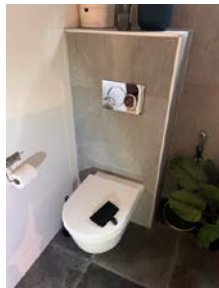
Veggmontert toalett og toalett dusj.
