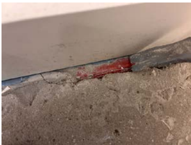
Hull på radonsperre.
