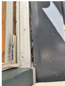
Løst beslag under hovedinngangsdør.
