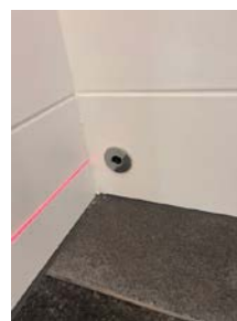
Drensåpning for innebygd blande batteri.
