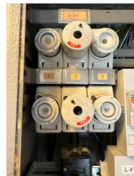
Sikringssskap med automatsikringer.
