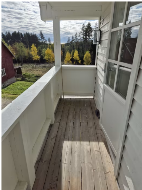
Viser balkong i trekonstruksjoner.
