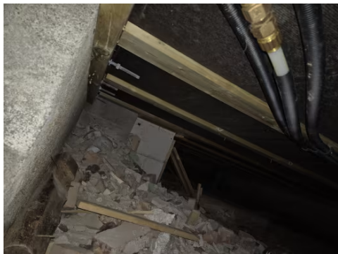
Viser del av kryptkjeller fra åpning.
