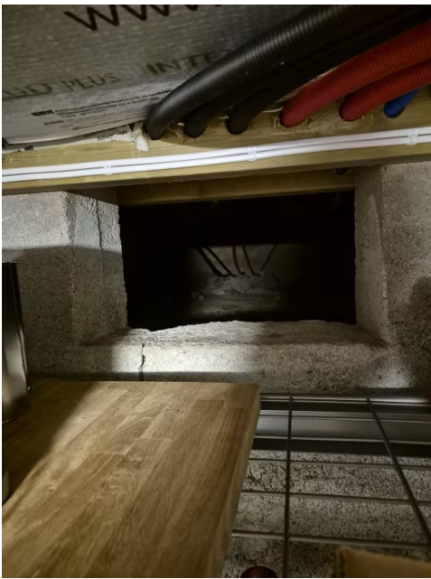
Viser åpning i grunnmur fra kjeller.
