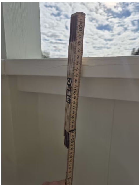
Viser målt rekkverkshøyde, rekkverket blir målt til 96 cm. og er lavere enn forskriftskravet på 100 cm.
