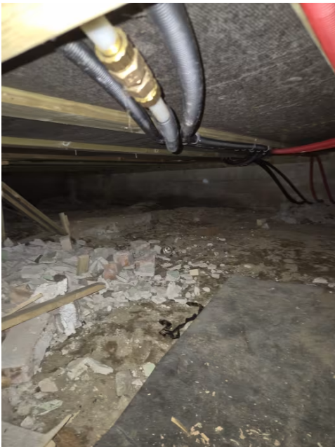
Viser del av krypkjeller fra åpning.
