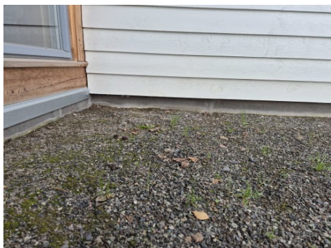
Viser kort avstand fra terreng til panel.
