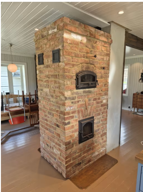
Viser pipe med Massovn med peisdell og bakerovn i kjøkken.
