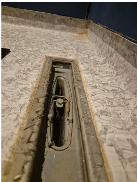
Viser sluk, klemring og mansjett.
