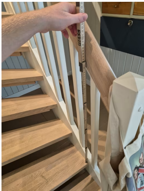
Viser målt høyde rekkverk, rekkverk tilfredsstillende krav på 90 cm.
