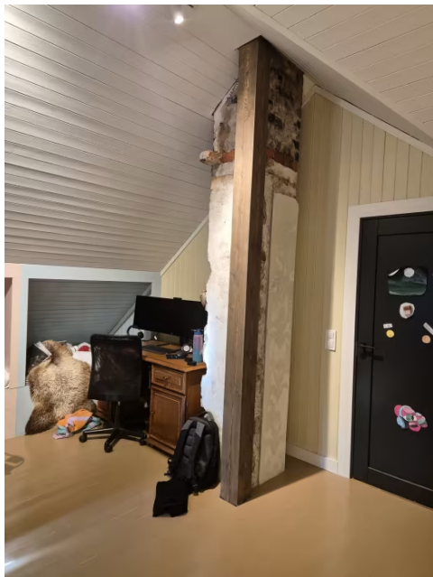
Viser pipe 2. etasje.
