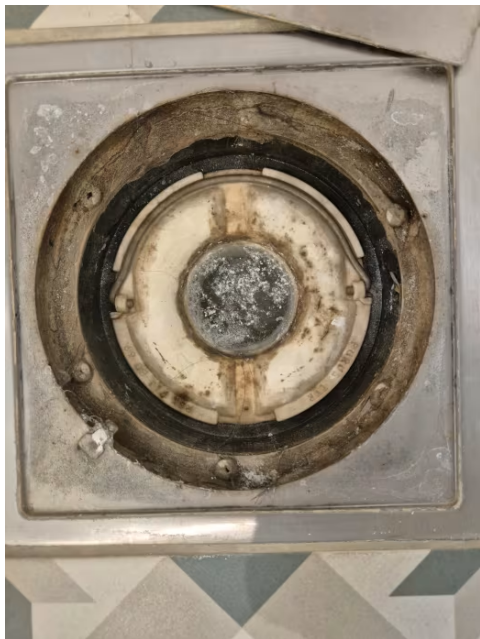
Viser sluk, klemring og mansjett.
