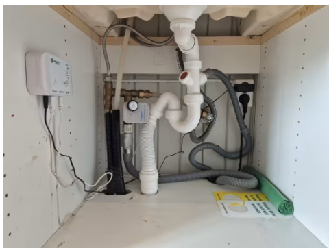
Viser vann- og avløpsinstallasjoner under kum.
