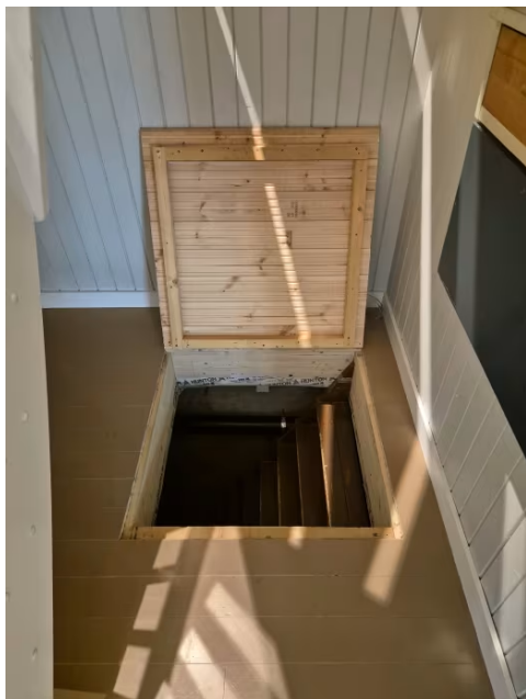
Viser tilkomst til rom under terreng via luke i gulv.
