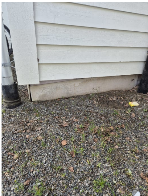
Grunnmur er utvendig isolert, grunnmursplast og belagt med fasade/grunnmursplater, utvendig grunnmur ikke tilgjengelig for kontroll.
