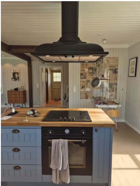
Viser ventilator med mekanisk vifte over stekesonen.
