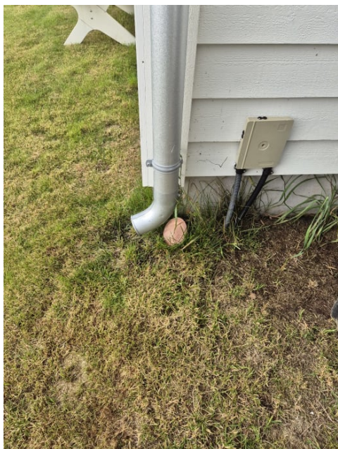
Et nedløp er ikke tilknyttet avløpsanlegg i grunn, her er det etablert utkast med godt terrengfall.
