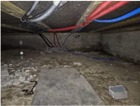
Viser del av krypkjeller fra åpning.
