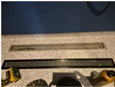
Viser sluk, klemring og mansjett.
