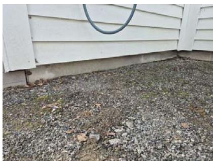
Viser kort avstand fra terreng til panel.
