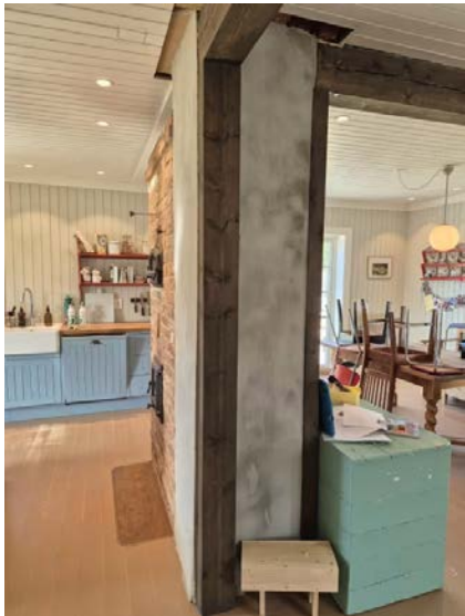
Viser pipe 1. etasje.
