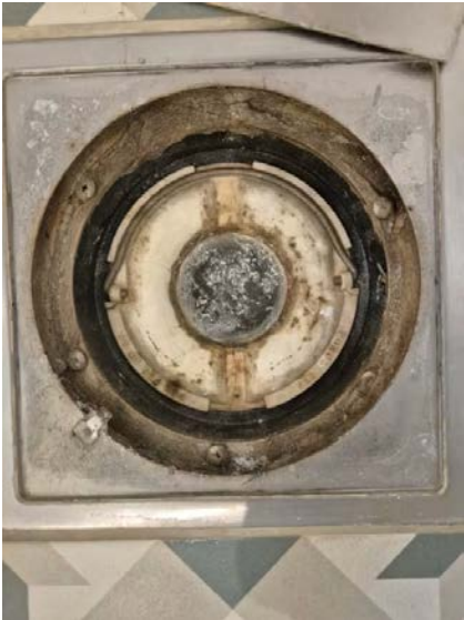
Viser sluk, klemring og mansjett.
