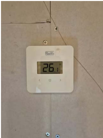
Viser eksempel av romtermostat.
