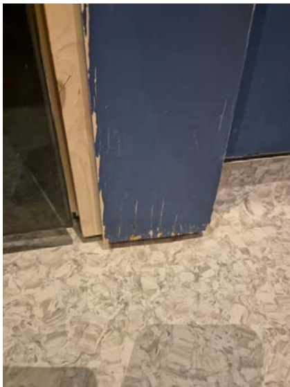
Viser dør er plassert i våtsone, dør med karm og listverk vil ikke tåle belastningen av fritt vann.
