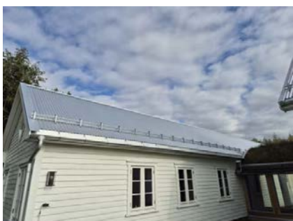
Viser etablerte snøfanger på tekking.
