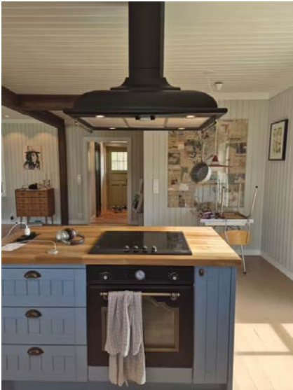
Viser ventilator med mekanisk vifte over stekesonen.
