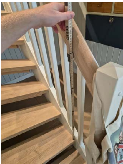
Viser målt høyde rekkverk, rekkverk tilfredsstillt krav på 90 cm.
