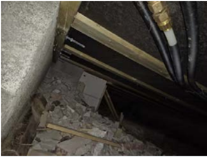
Viser del av krypkjeller fra åpning.
