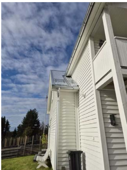
Viser etablerte snøfanger på tekking.
