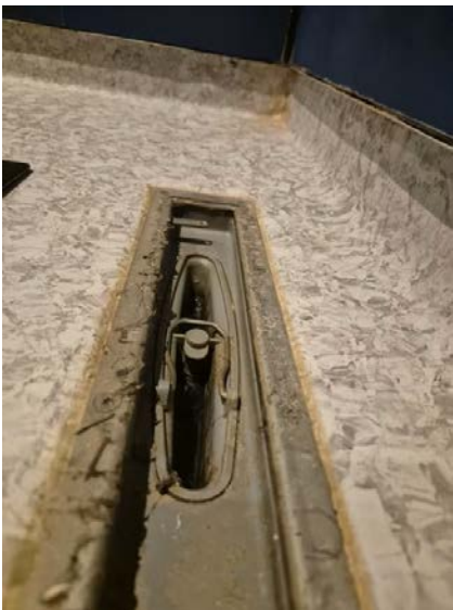
Viser sluk, klemring og mansjett.
