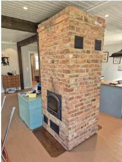
Viser pipe med Massovn med peisdel og bakerovn i kjøkken.
