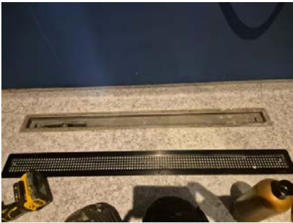
Viser sluk, klemring og mansjett.
