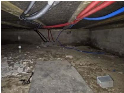
Viser del av krypkjeller fra åpning.
