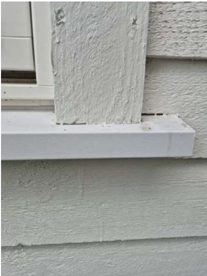
Viser eksempel av panel som har kort avstand til vannbrett/beslag.
