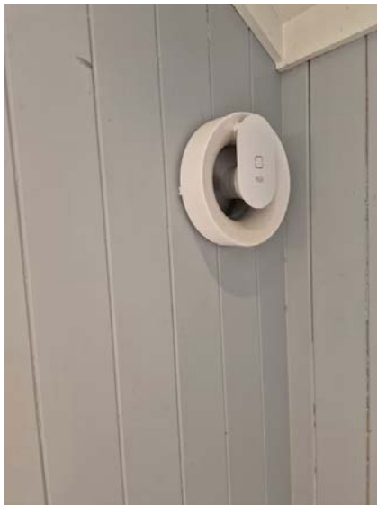
Viser ventilering med mekanisk vifte, avtrekk ført ut av vegg mot fri.
