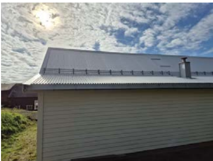
Viser etablerte snøfanger på tekking.
