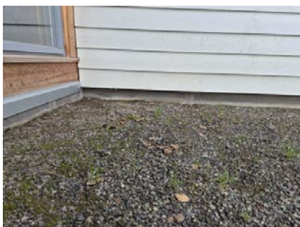
Viser kort avstand fra terreng til panel.
