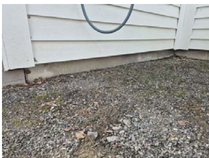
Viser kort avstand fra terreng til panel.
