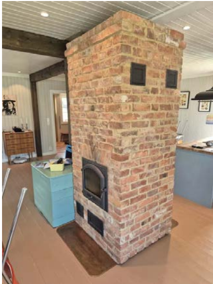
Viser pipe med Massovn med peisedel og bakerovn i kjøkken.
