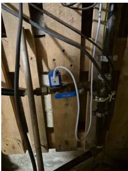
Viser hovedstoppekran plassert i kjeller, hovedstoppekran fungerer som tiltenkt.
