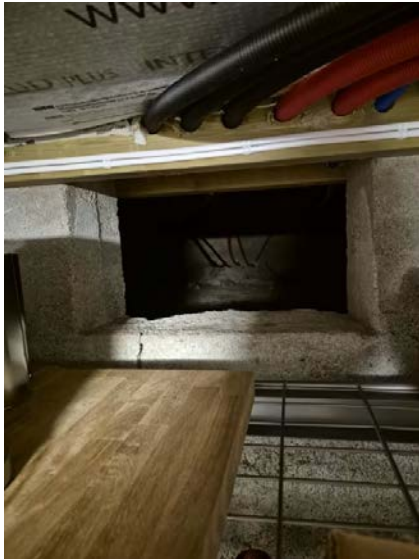
Viser åpning i grunnmur fra kjeller.
