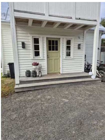
Viser terrasse i trekonstruksjoner.
