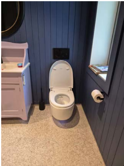
Viser vegghengt toalett med innebygget sisterner, toalett med spylefunksjon (Geberit Aquaclean)
