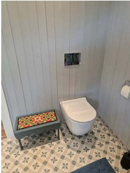
Viser vegghengt toalett med innebygget systerne.
