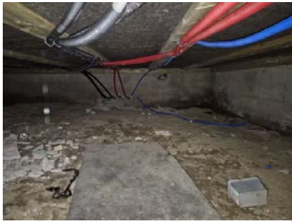
Viser del av krypkjeller fra åpning.
