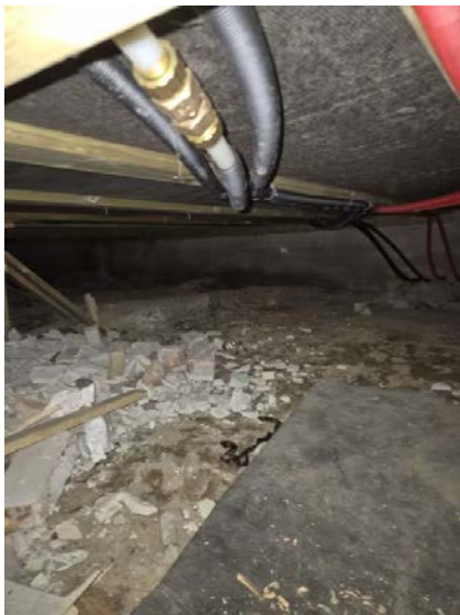
Viser del av krypkjeller fra åpning.
