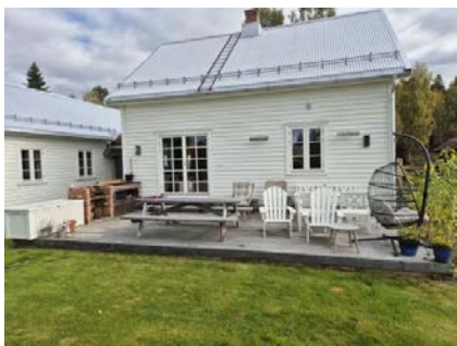
Viser terrasse i trekonstruksjoner.
