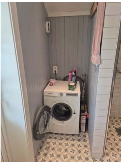
Viser plass og opplegg for vaskemaskin.
