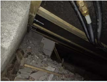
Viser del av krypkjeller fra åpning.
