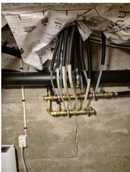
Viser hovedstoppekran plassert i kjeller, hovedstoppekran fungerer som tiltenkt.
