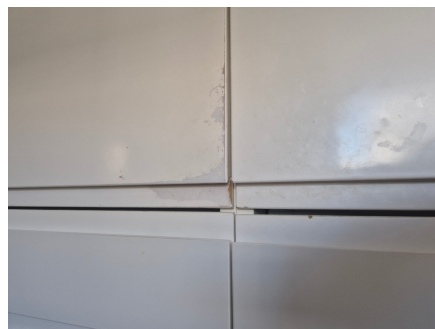
Slitasje på front til kjøl/fryseskap.
