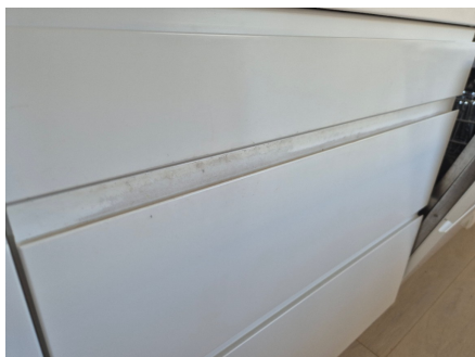
Slitasje på front under vaskecum.
