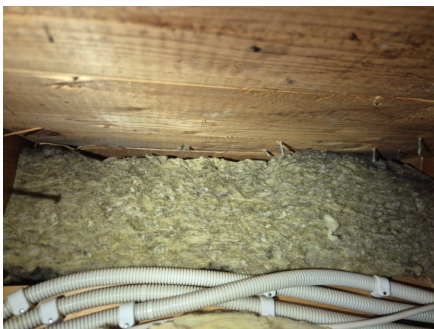
Liten luftespalte over takkonstruksjon.
