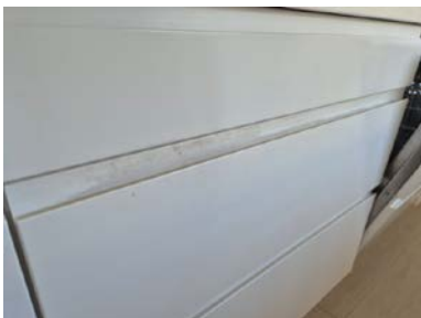
Slitasje på front under vaskecum.
