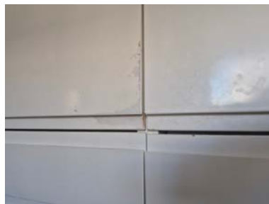
Slitasje på front til kjøl/fryseskap.
