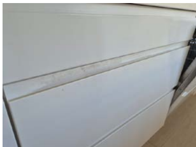
Slitasje på front under vaskecum.
