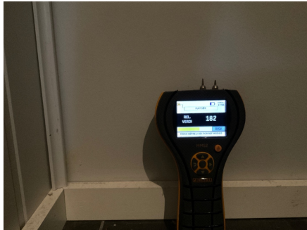
Fuktmåling på overflate under bakkenivå
