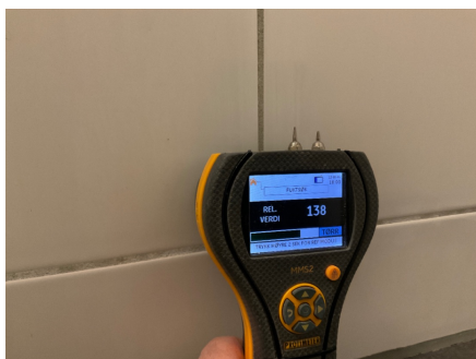
Fuktmåling på overflate i dusjsone
