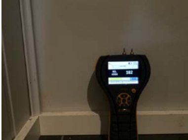
Fuktmåling på overflate under bakkenivå
