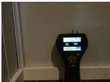
Fuktmåling på overflate under bakkenivå
