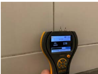
Fuktmåling på overflate i dusjsone
