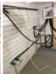
Rør i rør m fordelerskap
