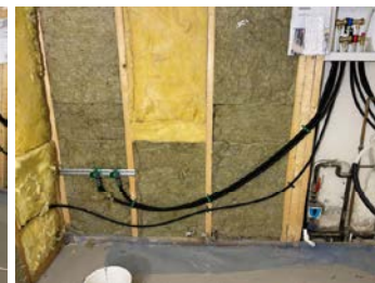
Rør i rør m fordelerskap
