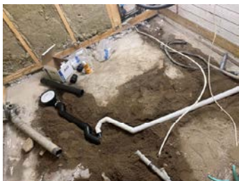
Gulv pigger opp og nye rør lagt
