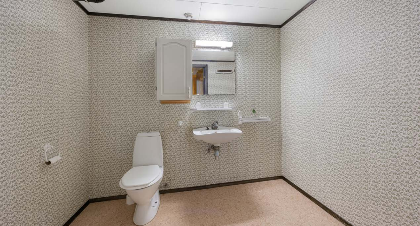
Wc-rommet har belegg på gulvet og tapetserte vegger. Videre er det enkel servant, veggskap, speil med belysning og gulvmontert toalett.
