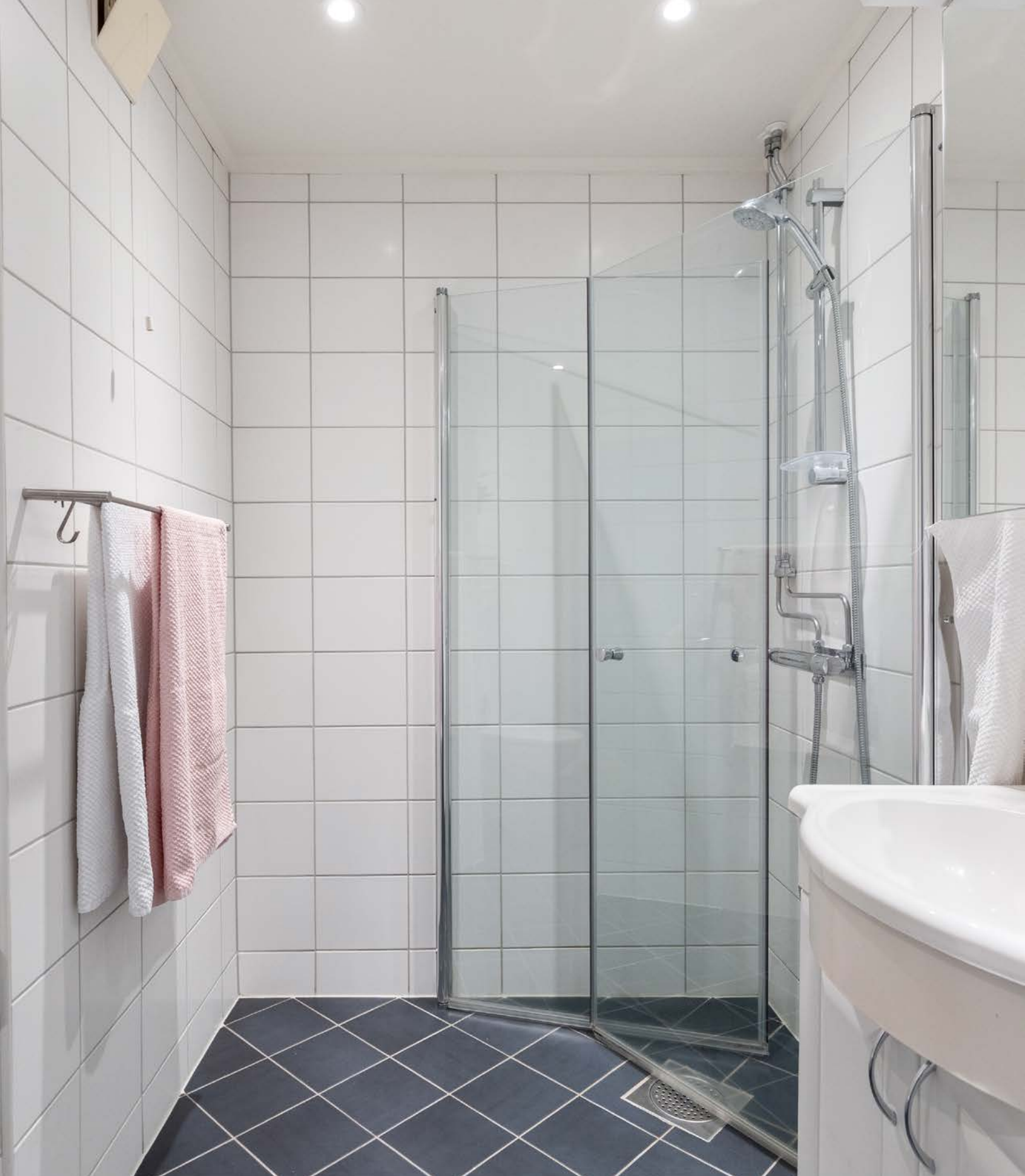
Badet har fliser med varmekabler på gulv, fliser på vegger, og malte plater med innfelte downlights i himling.
