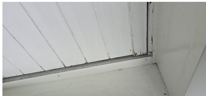
ned kant terrasse dør
