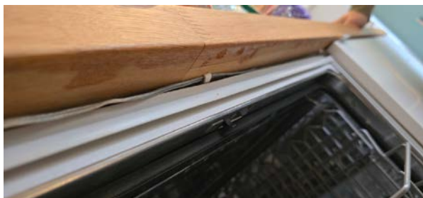
underside benkeplate oppvaskmaskin
