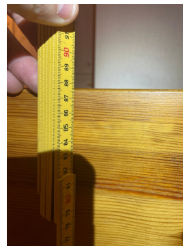
87,5 cm høyde rekkverk trapp 2.etg
