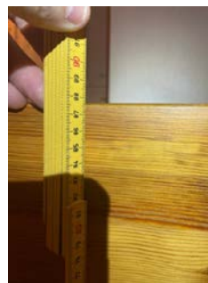
87,5 cm høyde rekkverk trapp 2.etg
