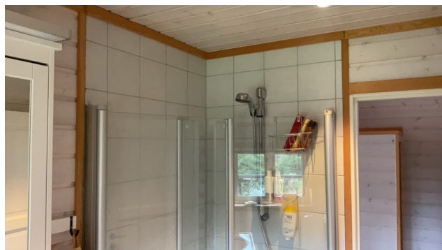
Trepanel og dør er plassert i det som ansees som våtsone
