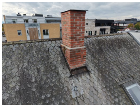
Pipe er rehabilitert over tak i 2020.
