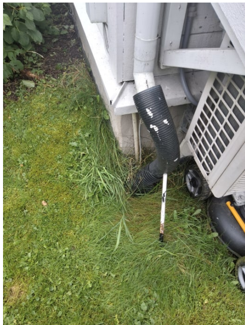
Taknedløp er ledet til drenerør.
