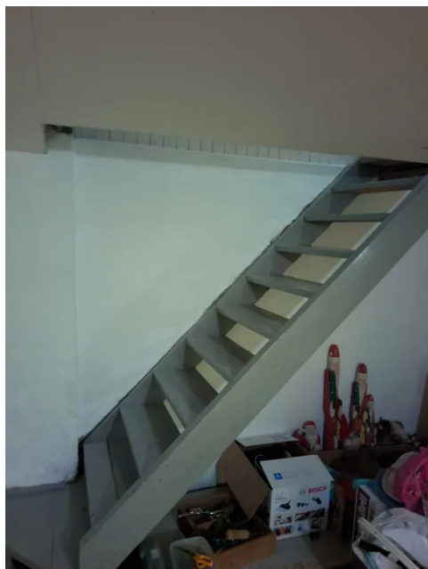
Åpen trapp mellom kjelleretasje og 1. etasje.
