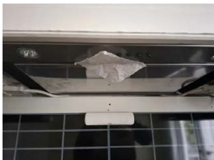
Avtrekkseffekten er testet med papir.
