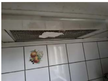
Avtrekkseffekt er testet med papir.
