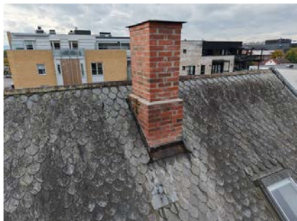
Pipe er rehabilitert over tak i 2020.
