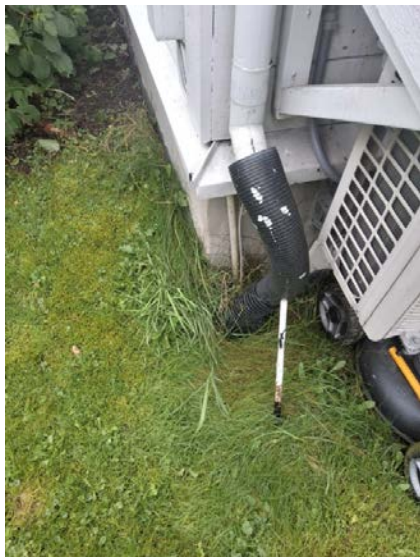
Taknedløp er ledet til drensrør.
