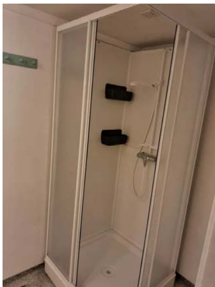
Det er montert dusjkabinett på badet.
