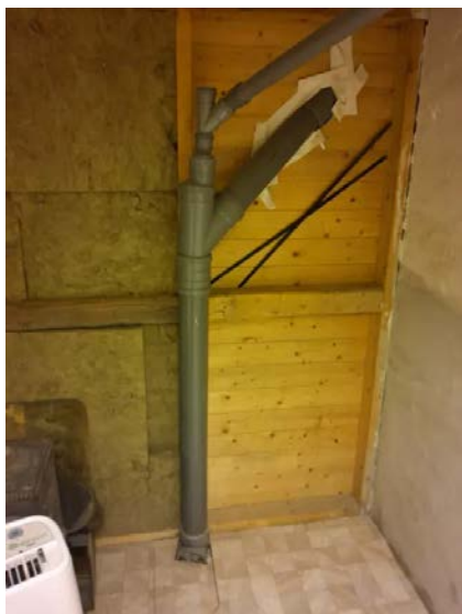
Avløpsrør av plast i kjeller.
