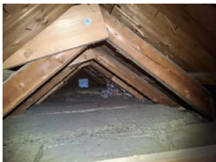
Det er montert lufteventiler i gavlvegger.
