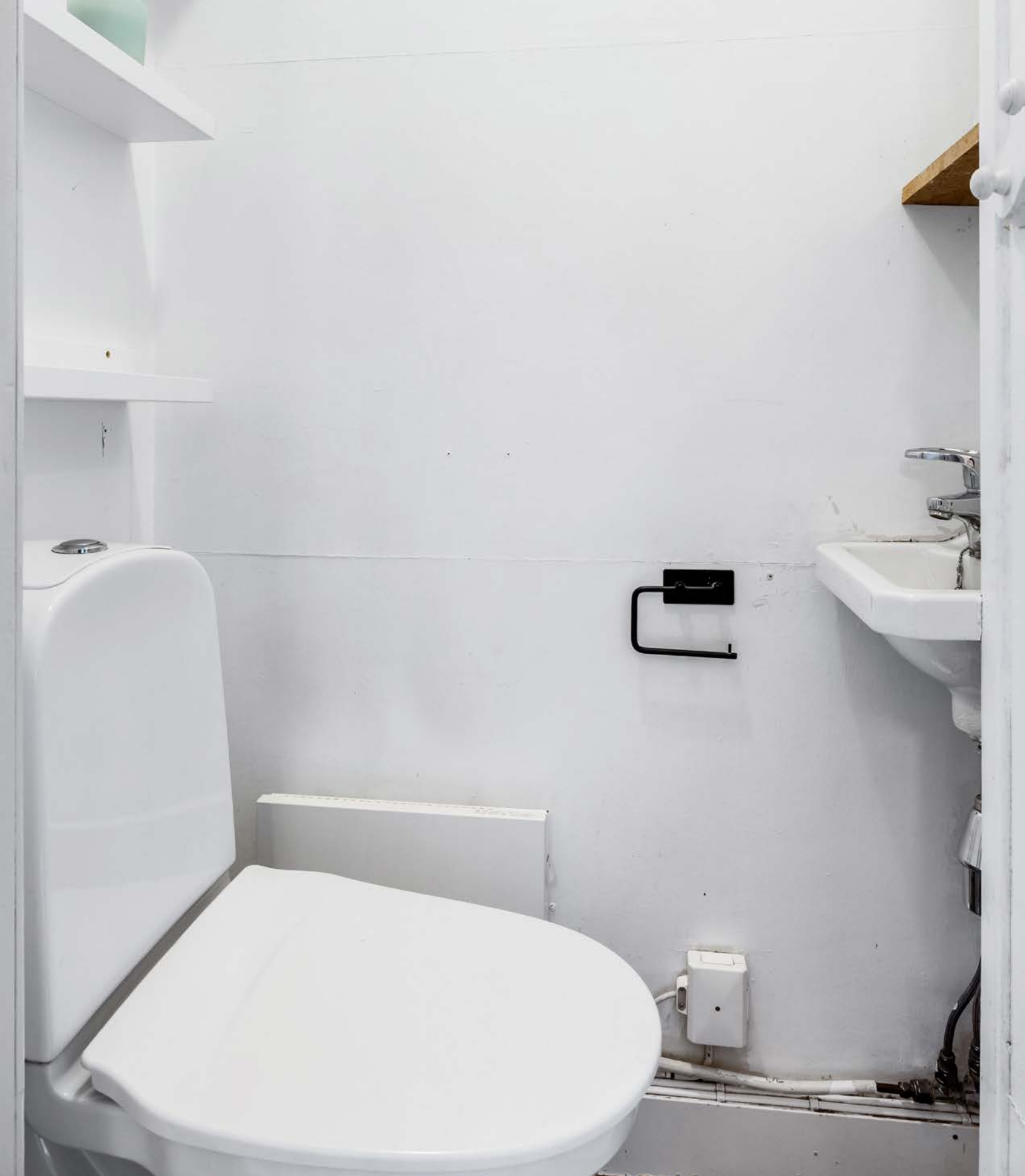
Enkelt, lite toalettrom i 1. etasje med gulvmontert toalett og veggmontert håndvask.
