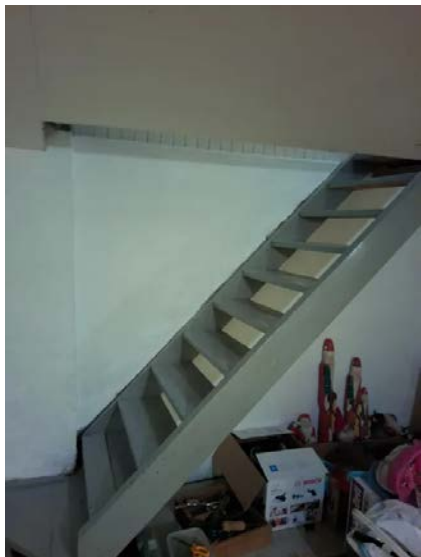
Åpen trapp mellom kjelleretasje og 1. etasje.
