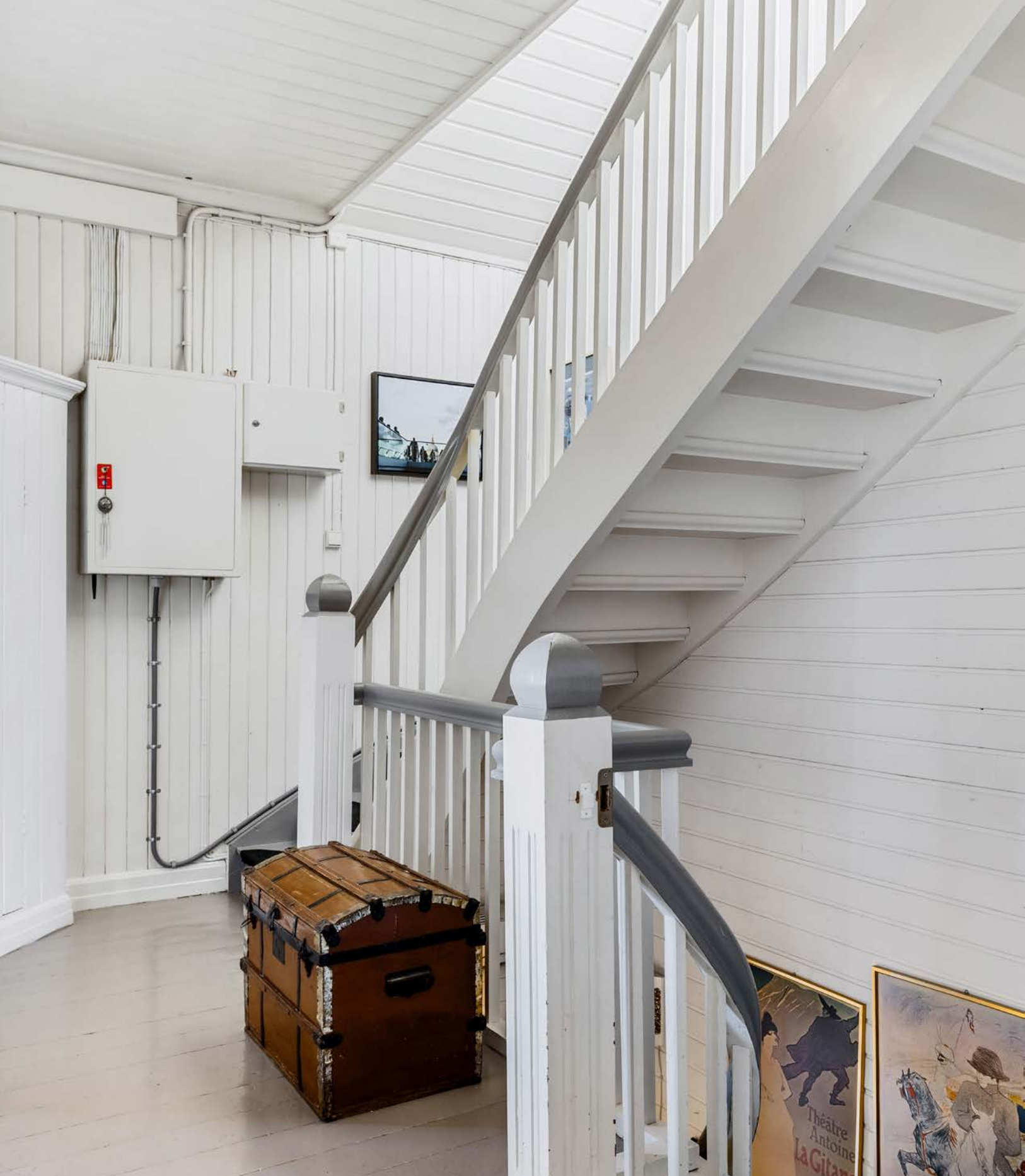
Trappegang med trapp videre opp til loftetasjen.
