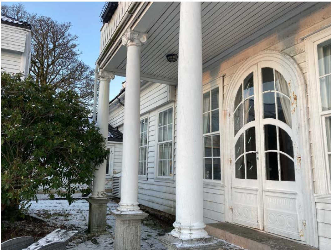
Foto: A. Hoff 09.12.2022 Hagedøren D-V-1-01 og himling under altanen
