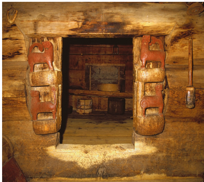
Stabburet på gården Berdal sudistog, Nesland i Telemark, er en middelalderbygning og følger automatisk fredet. Dette er ikke bare en svært gammel bygning. Beitskiene på begge sider av døråpningen er spesielle, sjeldne og vakre. Stabburet har vært ivaretatt av mange generasjoner eiere gjennom århundrene. I tillegg er det underlagt kulturminnelovens beskyttelse som et nasjonalt kulturminne. Foto: Birger R. Lindstad, NIKU.
