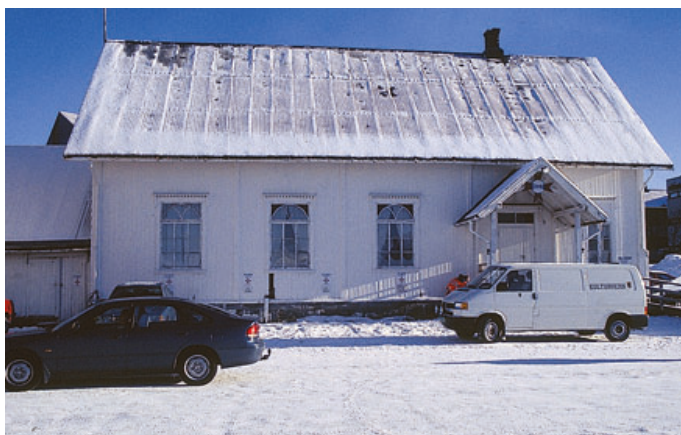
Midlertidig fredning kan forhindre at verdifulle bygninger blir revet. I september 1997 gikk Nordland fylkeskommune til midlertidig fredning av den over 100 år gamle avholdslosjebygningen i Mo i Rana. Til tross for dette vedtaket ble bygningen revet i mars 1998. Utbyggeren ble idømt ett års fengsel for grov overtredelse av kulturminneloven. Foto: Edvard Olav Forselv.
