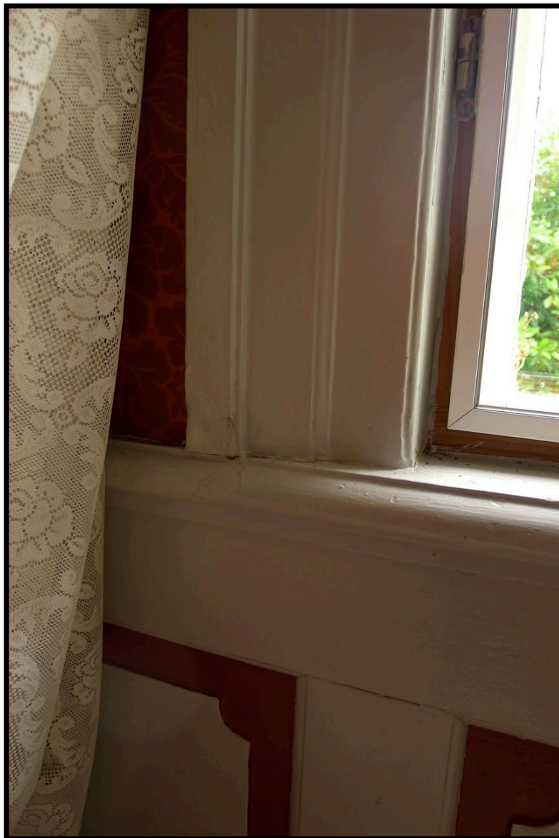
Nye gerikter og brystning i spisestuen. Plater på vegg.
