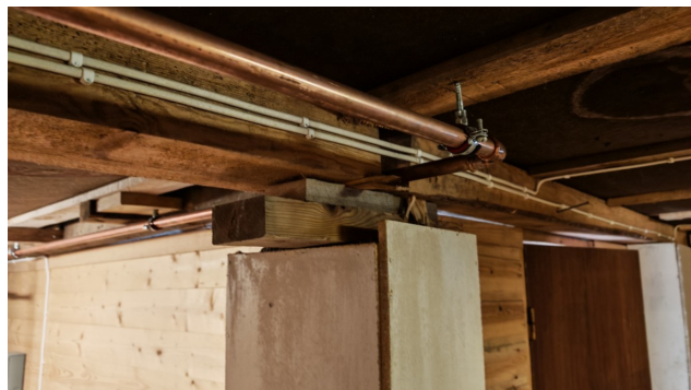
Provisorisk understøtte av bjelkelag.
