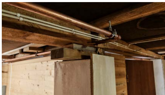
Provisorisk understøtte av bjelkelag.
