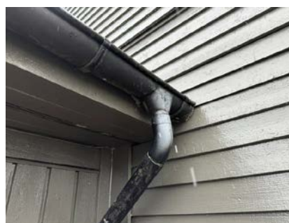
Takrenne og nedløp.
