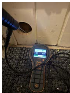
Hulltaking og fuktmåling i vegg.
