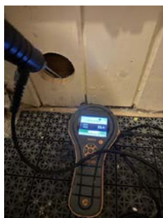
Hulltaking og fuktmåling i vegg.
