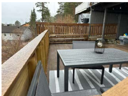
Veranda i underetasje.
