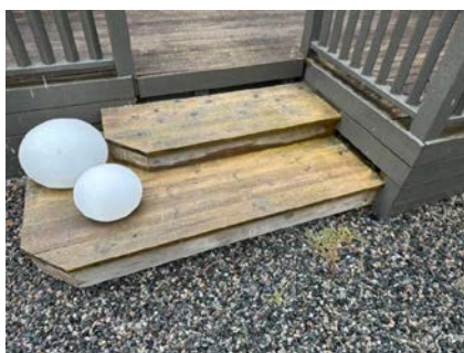
Trapp til inngang.
