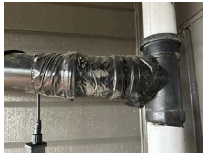
Teip på nedløpsrør
