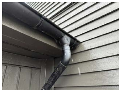
Takrenne og nedløp.
