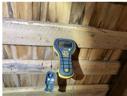
Ved enkel fuktmåling registrerte jeg tørre verdier.
