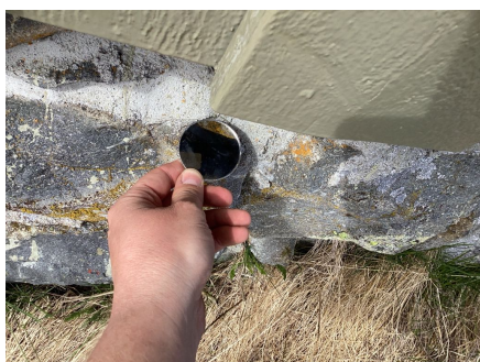
Det er observert åpninger i utvendig komplettering som øker risikoen for at mus kan komme inn.
