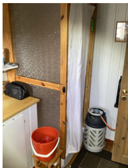
Dusjkabinett med forheng og avløpsrør rett ut.
