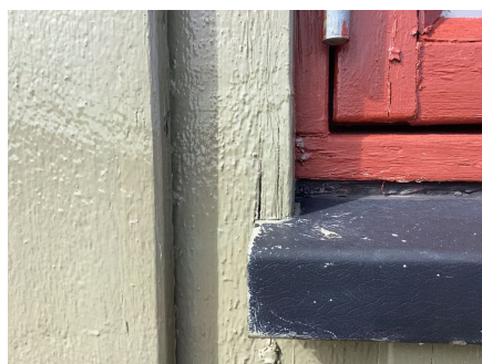
Kledning er ført ned på vannbrett, risiko for fuktopptrekk.
