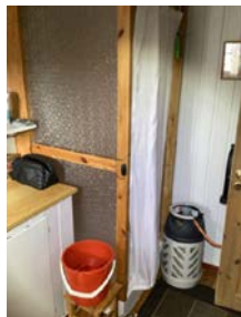
Dusjkabinett med forheng og avløpsrør rett ut.
