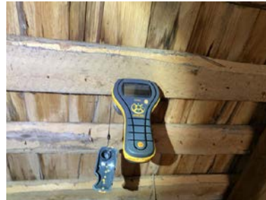
Ved enkel fuktmåling registrerte jeg tørre verdier.
