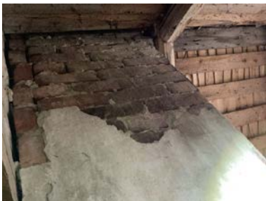
Puss er flasket av på pipe.
