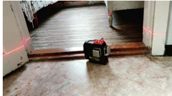
Målt høydeforskjell på over 30 mm gjennom hele rommet. Tilstandsgrad 3 gis med bakgrunn i standardens krav til godkjente måleavvik.
