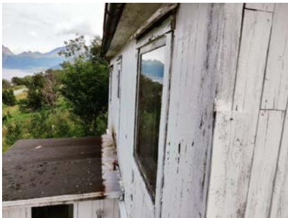
Manglende rekkverk.
