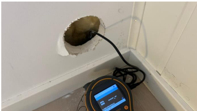
Fuktmåling i vegg under terreng.
