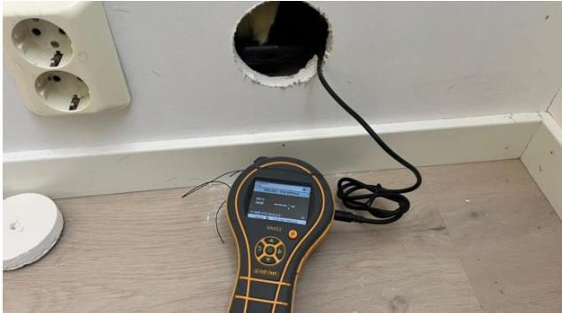
Fuktmåling inn mot dusjnisen
