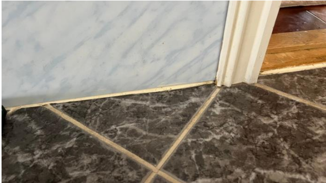
Feilmontering av baderomsplater
