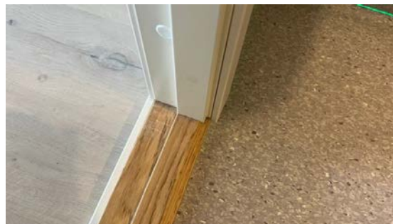
Eksempel på dør med justeringsbehov
