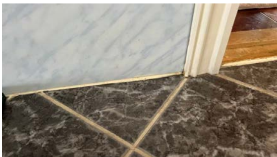
Feilmontering av baderomsplater
