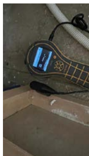
Fuktmåling i kassen bak toalettet
