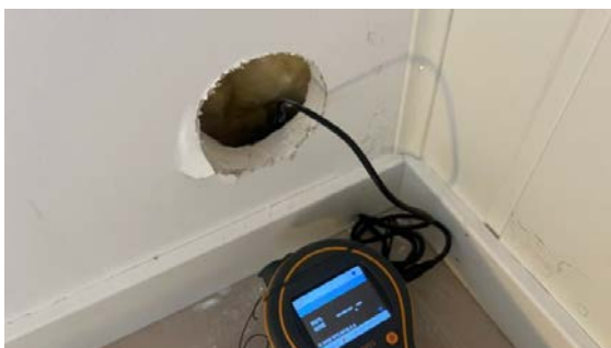
Fuktmåling i vegg under terreng.
