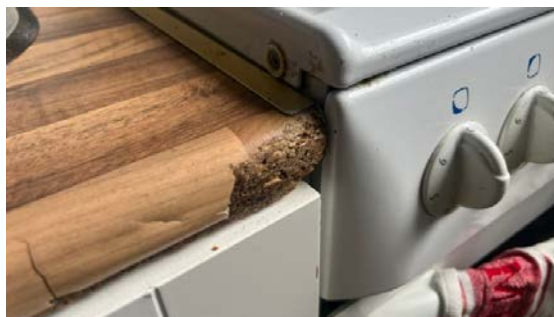
Eksempel på skade på kjøkkeninnredningen
