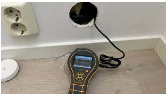
Fuktmåling inn mot dusjnisen
