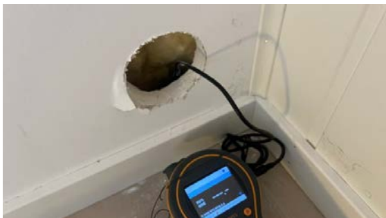
Fuktmåling i vegg under terreng.
