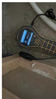
Fuktmåling i kassen bak toalettet
