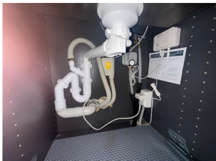
Røropplegg i kjøkkenbenk med Waterguard
