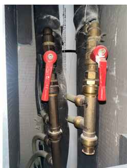
Røropplegg i kjøkkenbenk med Waterguard
