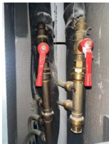
Røropplegg i kjøkkenbenk med Waterguard
