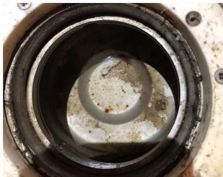
Bilde av sprekk i flisfuge
