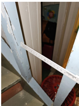
Åpning mellom spiler er over 10cm
