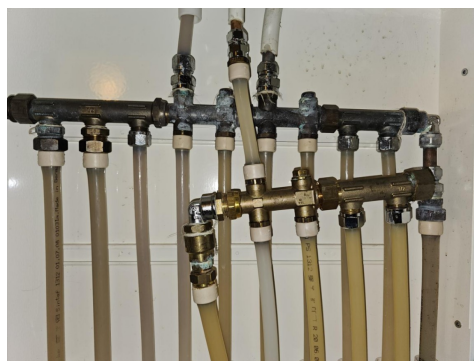
Forделerskap for rør-i-rør
