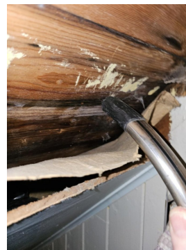
Noe fukt i himling/undertak ved pipe
