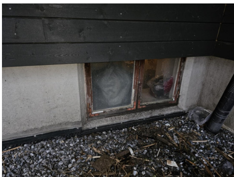
Vindu i vaskerom
