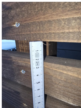
Åpning mellom spiler på over 20mm.
