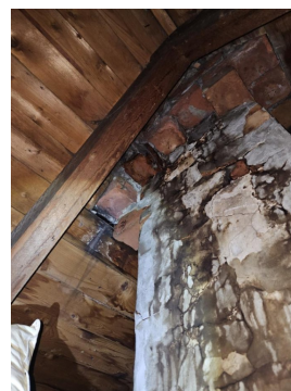
Noe fukt i himling/undertak ved pipe
