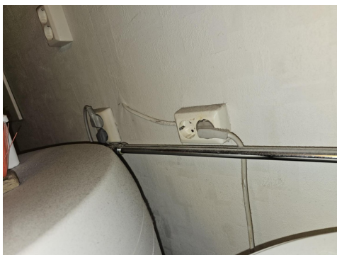
Beredere er tilkoblet strøm via stikk kontakt
