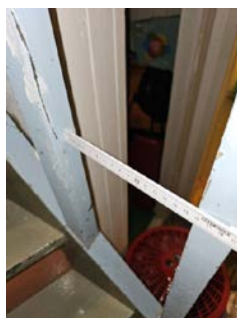
Åpning mellom spiler er over 10cm
