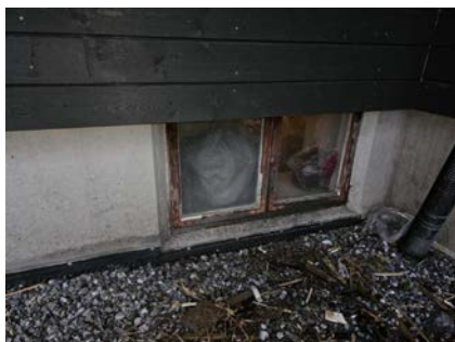
Vindu i vaskerom
