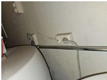
Beredere er tilkoblet strøm via stikk kontakt
