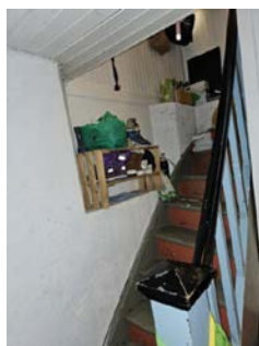
Åpning mellom spiler er over 10cm
