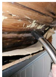
Noe fukt i himling/undertak ved pipe
