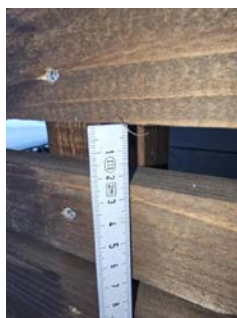
Åpning mellom spiler på over 20mm.
