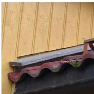
Megler beslag mellom vegg og tak tilbygg
