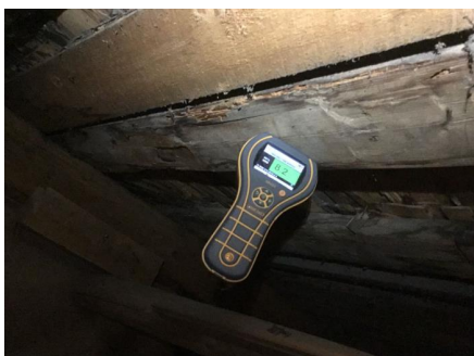
Ved enkel fuktmåling registrerte jeg tørre verdier.
