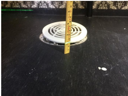
Motfall mot dør er registrert.
