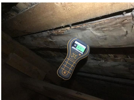
Ved enkel fuktmåling registrerte jeg tørre verdier.
