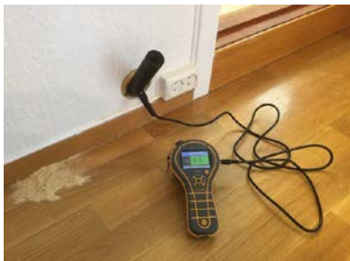
Hulltaking utført fra tilstøtende rom.
