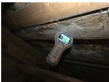
Ved enkel fuktmåling registrerte jeg tørre verdier.
