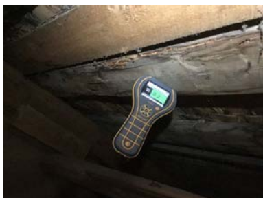
Ved enkel fuktmåling registrerte jeg tørre verdier.
