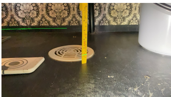
Målt motfall mot sluk: 21mm
