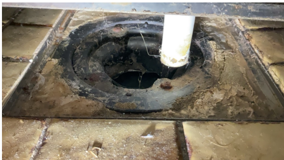
Kontroll av sluk. Ingen synlig slukmansjett i sluk.
