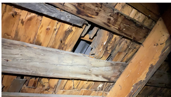
Hull i undertak.
