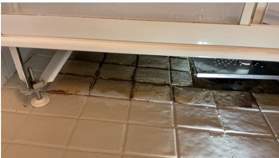
Fliser på gulv er malt, men ikke under dusjkabinett.
