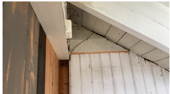
Eldre strømkabler er koblet sammen med nyere anlegg. Ledning mellom koblingspunkt bør byttes.
