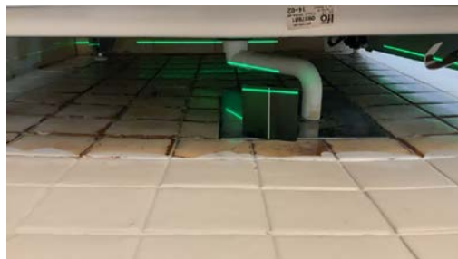
Målt fall till sluk: 22 mm.
