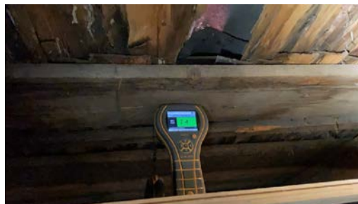
Råteskade på undertak. Denne er trolig gammel og var tørr ved befaring.
