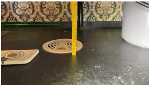
Målt motfall mot sluk: 21mm
