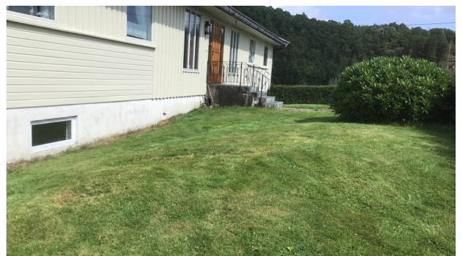
Fall mot grunnmur
