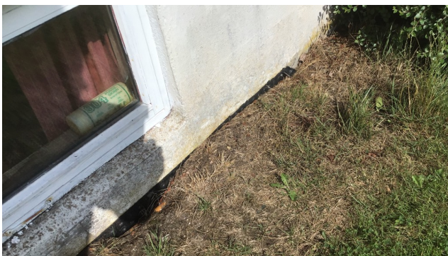
Grunnmurs plast synlig på begrenset område
